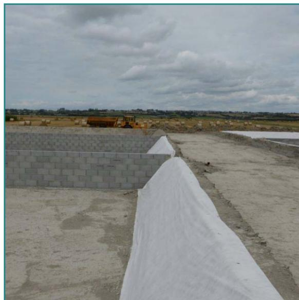
Murs de séparation des bassins pour constituer six casiers qui fonctionneront en alternance. Ces bassins seront bâchés avant d'être remplis de différents granulats pour filtrer les effluents qui repartiront ensuite dans le système de lagunage actuel.
